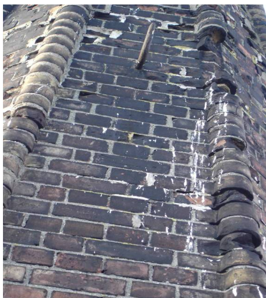
Ryc. 10 a, b. Ubytki cegieł w płaszczu i w żebrach iglicy wieży powodują jej ciągłe przemakanie – widok od zewnątrz i od wewnątrz ceglanej wieży. Źródło: fot. H. Rutyna, XII.2008 Fig. 10 a, b. Losses of bricks in the coat and in ribs of the spire of the tower cause constant getting soaked for her - view from the outside and from the inside of brick tower. Source: photo H. Rutyna, XII.2008
