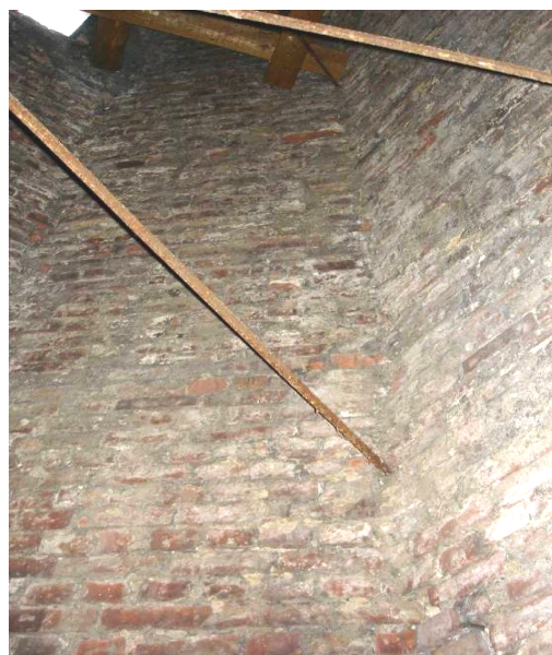
Ryc. 10 a, b. Ubytki cegieł w płaszczu i w żebrach iglicy wieży powodują jej ciągłe przemakanie – widok od zewnątrz i od wewnątrz ceglanej wieży. Źródło: fot. H. Rutyna, XII.2008 Fig. 10 a, b. Losses of bricks in the coat and in ribs of the spire of the tower cause constant getting soaked for her - view from the outside and from the inside of brick tower. Source: photo H. Rutyna, XII.2008
