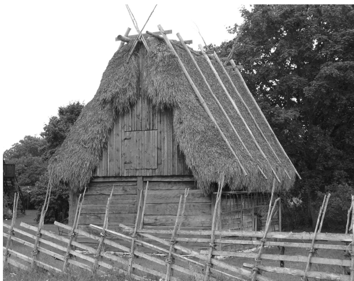
Ryc. 5. Strzecha agtak na starym budynku gospodarskim na prywatnej posesji koło miejscowości Stenkyrka. Źródło: fot. P. Arlet
