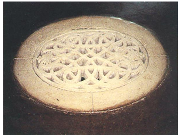
Fig. 10. Villa in Costozza. Marble rosette of the air intake. Source: Behling, 1996 Ryc. 10 Willa Costozza. Marmurowa rozeta nawiewu powietrza. Źródło: Behling, 1996
