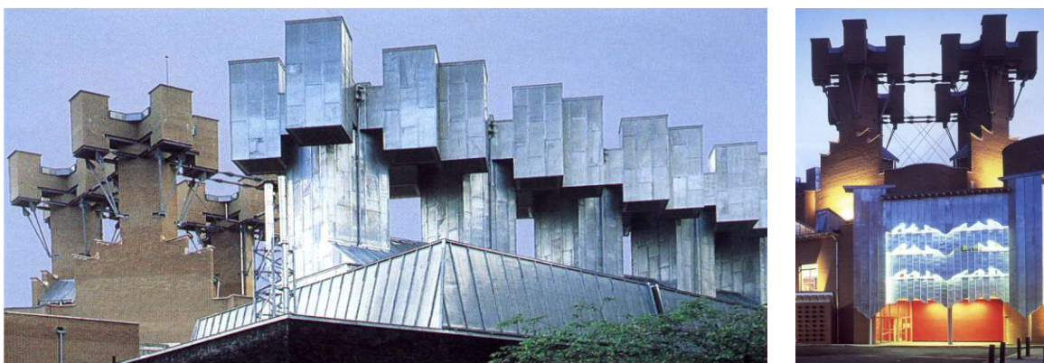
Fig. 21 Manchester – Contact Theatre. Forty-meter-tall gravity ventilation shafts. Source: FOCUS ON ZINC, 2000 Ryc.21 Manchester – Contact Theatre. 40-metrowej wysokości przewody wentylacji grawitacyjnej. Źródło: FOCUS ON ZINC, 2000
