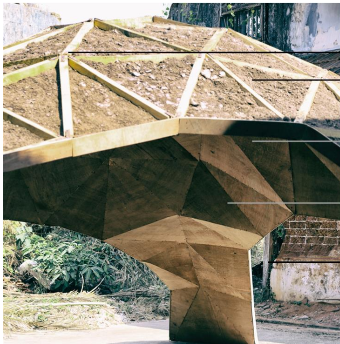
Fig. 7. Close-up to the construction detail of The Shell Mycelium Pavilion, 2016. Source: photo by Krishna & Govind Raja Ryc. 7. Zbliżenie na detal konstrukcji drewnianej pawilonu oraz jej wypełnienia z grzybni. The Shell Mycelium Pavilion, 2016. Źródło: zdjęcie: Krishna & Govind Raja
