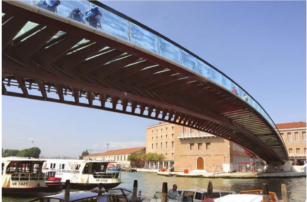
Fig. 1. Bridge of the "Ponte della Costituzione" of Venice. Italy. Arch. S. Calatrava. Source: Fot. S. Danylov. Ryc. 1. Most "Ponte della Costituzione" w Wenecji. Włochy. Źródło: Fot. S. Danylov.
