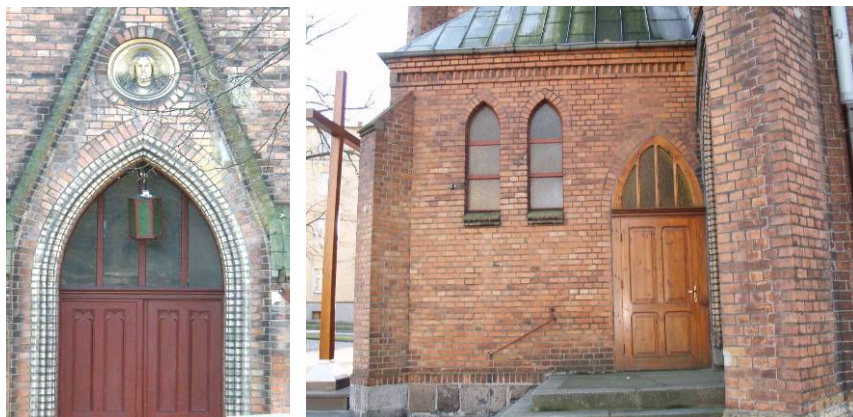
Ryc. 19 a, b. Stolarka drzwiowa portalu głównego; drzwi do zakrystii i ślusarka okienna w północnej klatce schodowej. Źródło: fot. H. Rutyna, XII.2008
