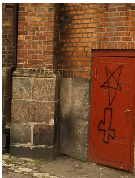
Ryc. 20. Styk cokołu granitowego (nawa kościoła) i cokołu betonowego (kaplica przy prezbiterium). Źródło: fot. H. Rutyna, XII.2008 Fig. 20 Contact granite plinth (the nave of the church) and the concrete plinth (the chapel at the presbytery). Source: photo H. Rutyna, XII. 2008
