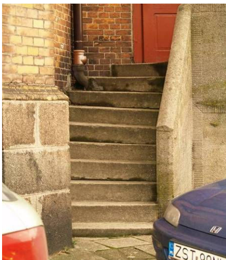
Ryc. 19. Schody zewnętrzne do kaplicy przy prezbiterium – od strony północnej. Źródło: fot. H. Rutyna, XII.2008
