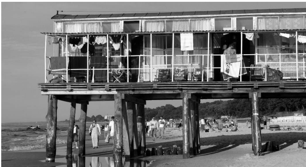
Fot. 2. Kołobrzeg, pozostałości tzw. rodzinnych łazienek plażowych – obiekt z roku 1903, odbudowany po pożarze w 1924 r., skrzydło wschodnie, stan 2007 r., fot. W. Bal.
