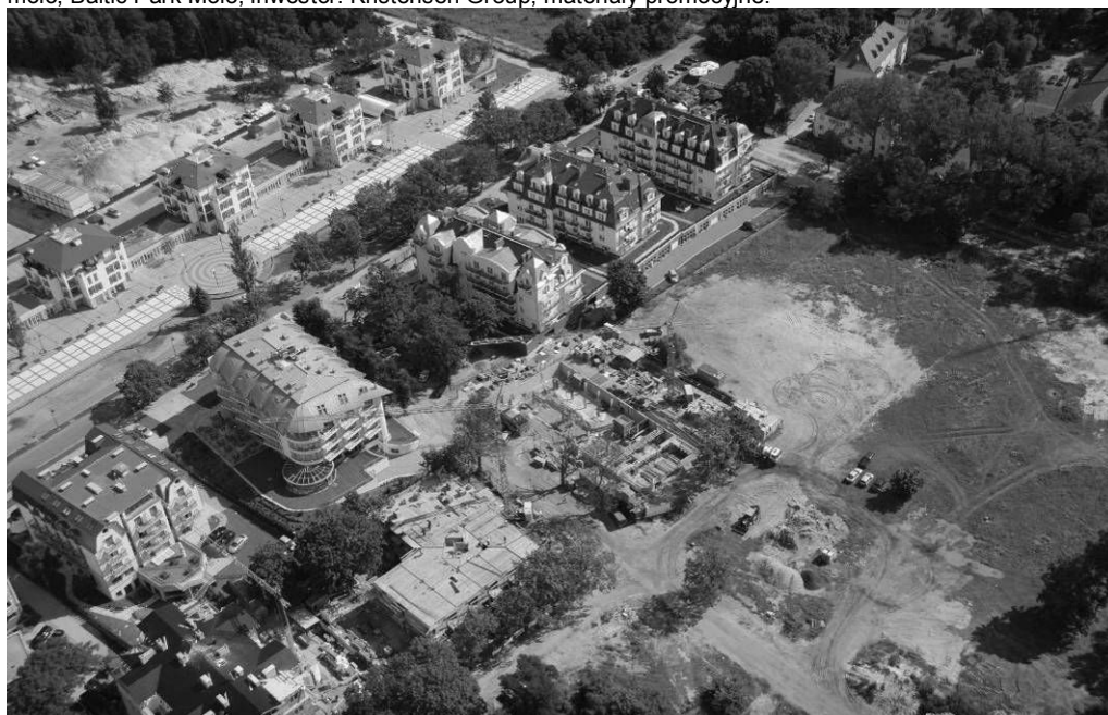
Fot. 10. Świnoujście, nowa zabudowa Dzielnicy Nadmorskiej, wydłużenie promenady w kierunku wschodnim, stan 2007 r., fot. C. Skórka.
