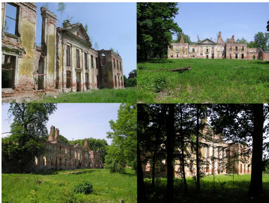
Ryc. 5. Aktualne fotografie zespołu pałacowo-ogrodowego w Gładyszach. Źródło: fot. M. Walerzak [7] Fig. 5. Actual photographs of the palace and garden complex in Gładysze. Source: photo M. Walerzak [7]
