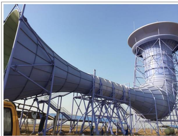
Fig. 2. Three coaxial wind turbines installed in the Venturi section of INVELOX. Source: Taghinezhad et al. 2019, p. 24 Ryc. 2. Trzy współosiowe turbiny wiatrowe zainstalowane w sekcji Venturi'ego w INVELOX. Źródło: Taghinezhad i in. 2019, s. 24
