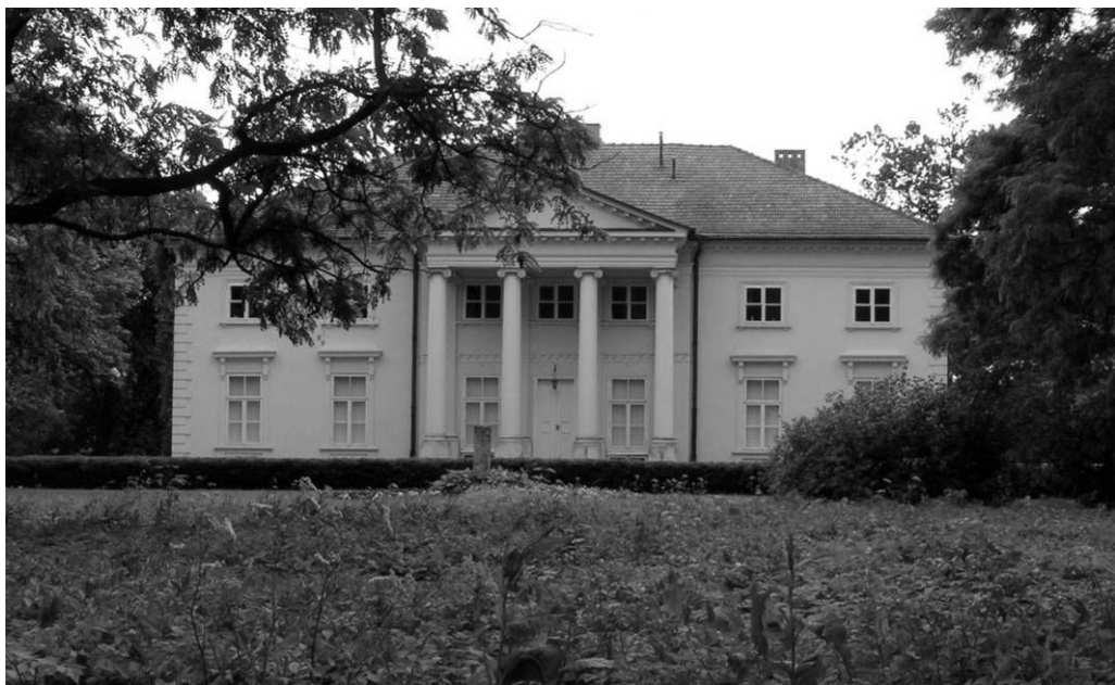
Fot. 2. Pałac w Igołomi. Źródło: autor.
