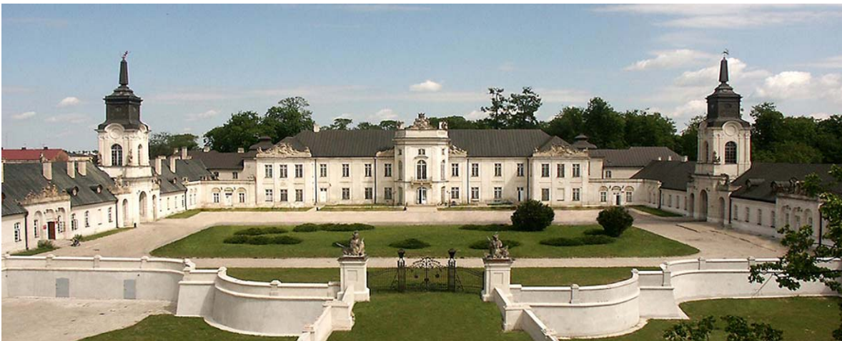
Fig. 1. Potocki Palace in Radzyń Podlaski in 2015-2019. Source: Lublin University of Technology (archive) Ryc. 1. Pałacu Potockich w Radzynie Podlaskim lata 2015-2019. Źródło: Politechnika Lubelska (archiwum)
