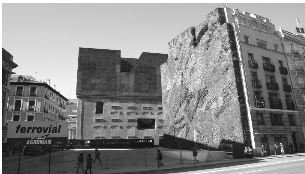
Fot. 4. Caixa Forum, proj. Herzog i de Meuron, Madryt. Źródło: foto, RB, 2008.
