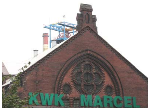
Ryc. 1. Neorenesansowy detal szczytu zabudowań KWK Marcel w Radlinie. Źródło: fot. K. Łakomy
