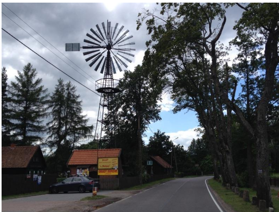
Fig. 6. Reconstruction of wind propelled pumps station - Zgon village. Source: W. Gadomska Ryc. 6. Odbudowana stacja pomp wiatrakowych w miejscowości Zgon. Źródło il. W. Gadomska
