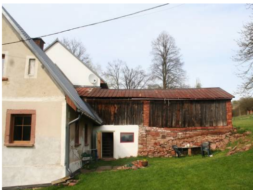
Ryc. 2. Przykład kamiennej podmurówki w części inwentarskiej. Źródło: fot. M. Ostrowska-Dudys Fig. 2. Example of stone foundations in livestock part of building. Source: photo M. Ostrowska-Dudys
