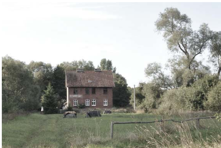
Ryc. 4. Dworzec kolejowy w Jarzeniu. Źródło: fot. E. Krawiecka
