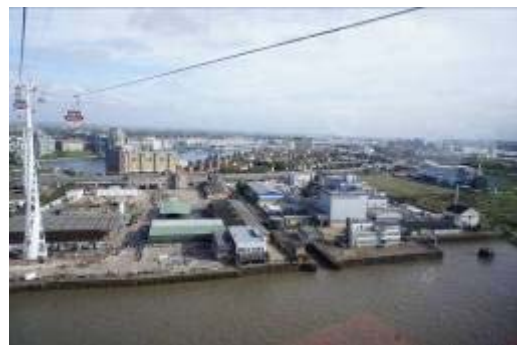
Ryc. 6. Emirates Air Line. Londyn. Źródło: fot. autor
