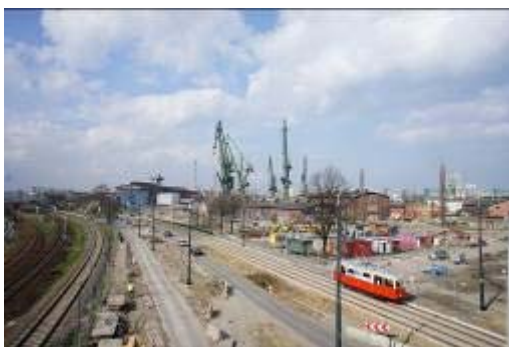
Ryc. 11. Stocznia Gdańska. Źródło: fot. autor Fig. 11. Gdańsk Shipyard Source: photo author
