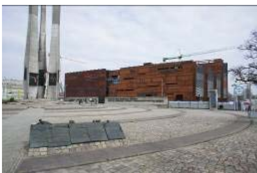
Ryc. 12. ECS. Źródło: fot. autor Fig. 12. ECS. Source: photo author
