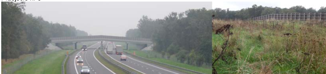
Ryc. 1. Przejsia: nr 1, nr 2, nr 3. Od lewej strony: widok na przejcie dla zwierzt od strony uzytkownikw drogi, widok na przejcie dla zwierzt od strony migrujcej zwierzyny. Źródło: fot. M. Mojecka
