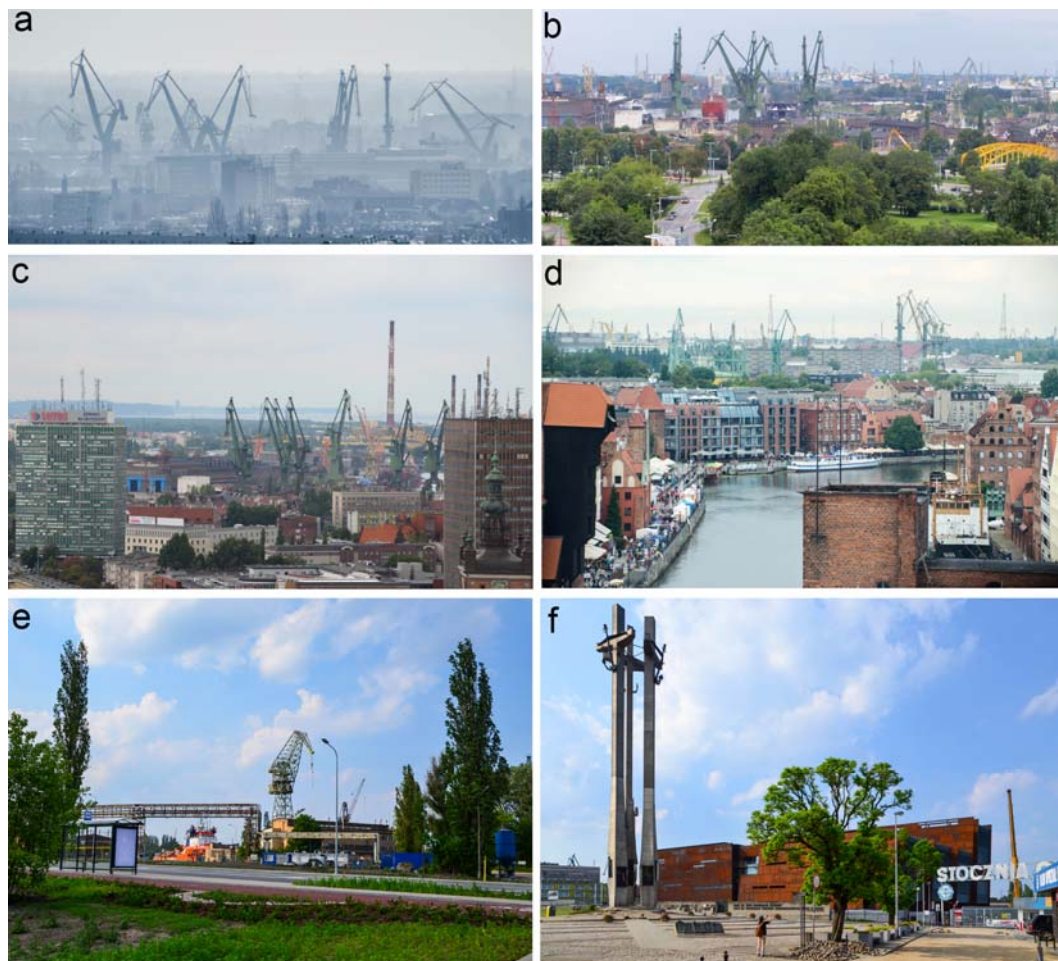
Ryc. 1. Górujące nad Gdańskiem stoczniowe żurawie są elementami silnie identyfikującymi przestrzeń. Dostrzegalne są z wszystkich ważnych punktów widokowych w centrum miasta, jak i poza nim. Widok na żurawie ze wzgórza Pacholek w Gdańsku-Oliwie (a); widok z Góry Gradowej (b); widok z wieży bazyliki Mariackiej (c); widok z ulokowanego na wyspie spichrzów koła młyńskiego (d); jest on tym bardziej wymowny, że pokazuje XX-wieczne żurawie w kontekście uznanego symbolu Gdańska, XV-wiecznej bramy-żurawia. Ujęcie to świadczy o wielowiekowej tradycji miejsca jako miasta portowego. Obecnie tereny postoczniowe zmieniają swoje przeznaczenie. Przez obszar jeszcze niedawno należący do stoczni dziś biegnie nowa droga – ul. Nowa Wałowa (e), wprowadzając na „niedostępne” wcześniej tereny miasto (inwestycja ta jest kluczowa dla realizacji komercyjnej zabudowy przez nowego właściciela). Przestrzeń, o której mowa, niesie w sobie także inne wartości materializujące się w architekturze m.in. Pomnika Poległych Stoczniowców i Europejskiego Centrum Solidarności (f). Źródło: fot. autor.
