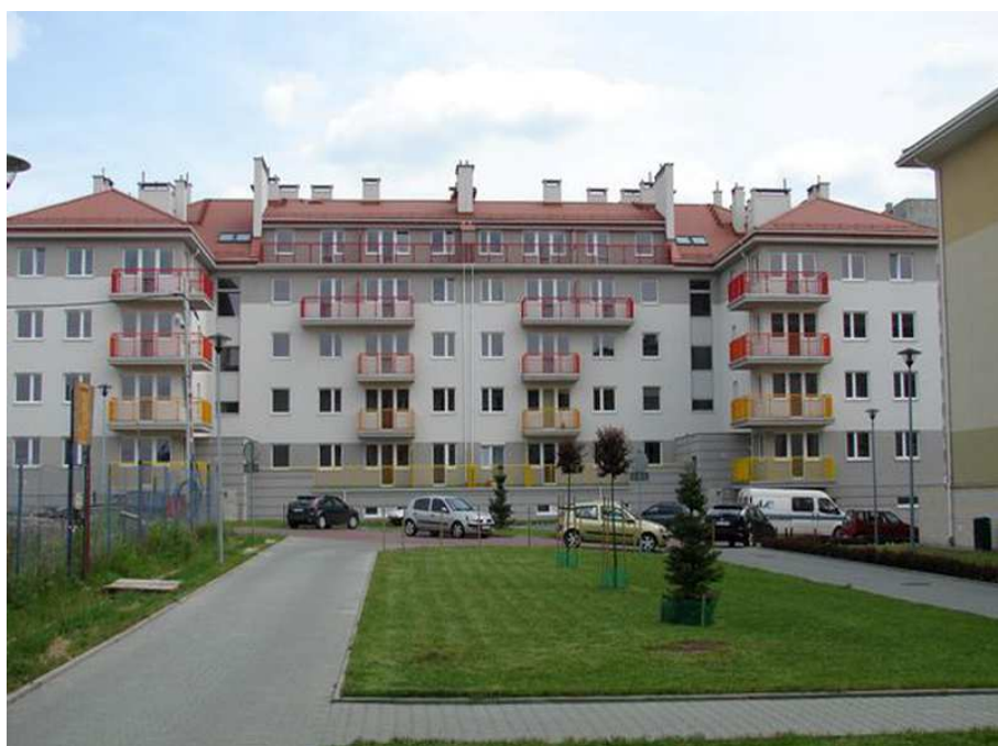
Ryc. 1. Osiedle Akademickie przy ul. Bora Komorowskiego w Krakowie, Budynek nr 7, elewacja zachodnia. Źródło: www.akropol.com
