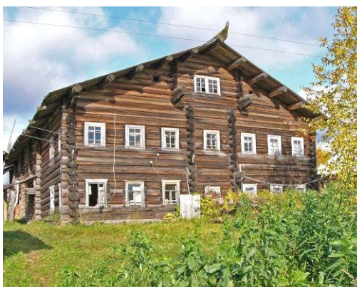
Ryc. 8. Dwukondygnacyjny budynek mieszkalny z poddaszem użytkowym, część frontowa z charakterystycznym „konikiem” na końcu belki kalenicowej. Werkoła, Rosja. /fot. autorka, 2008/
