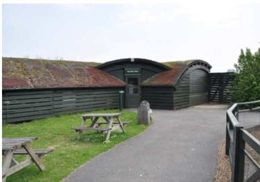
Ryc. 2. Jeden z typowych schronów obserwacyjnych w LWC na szlaku zwiedzania – miejsce do edukacji ekologicznej i obserwacji awifauny w rezerwacie - architektura znakomicie wkomponowana w przyrodniczy charakter obiektu, a główny nacisk położono na rozwiązania ekologiczne. Źródło: il. autora
