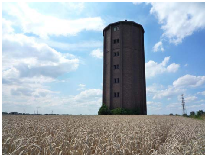
Ryc. 13. Wieża ciśnień w Inowrocławiu. Źródło: il. autora
