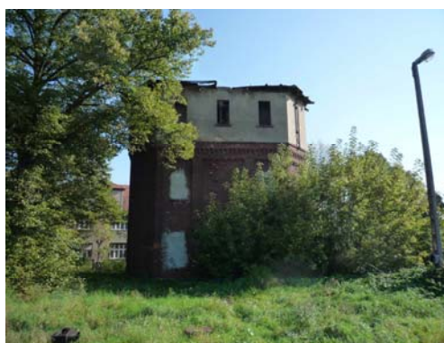
Ryc. 4. Wieża ciśnień w Janowcu Wlkp. Źródło: il. autora.
