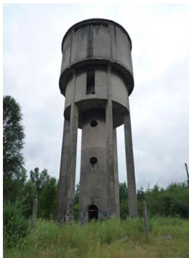
Ryc. 11. Wieża ciśnień w Brodnicy. Źródło: il. autora
