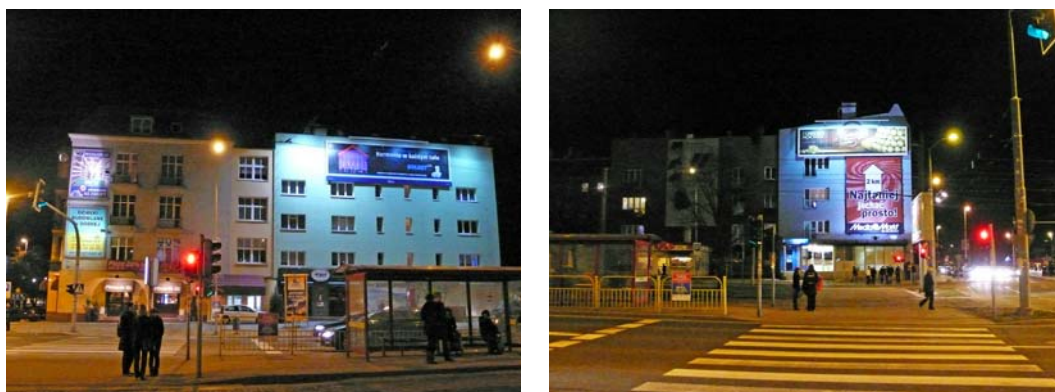
Ryc. 14, 15. Intensywnie podświetlane o zmierzchu reklamy na elewacjach budynków mieszkalnych. Szczecin, pl. Kościuszki. Zdjęcia: M. Czyński
