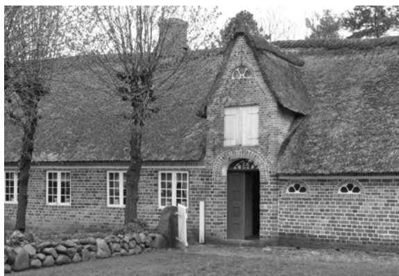
Ryc. 3. Facjatka nad głównym wejściem do budynku z miejscowości Sejerslev Południowy (obecnie w skansenie Sorgenfri koło Kopenhagi). Po lewej stronie pomieszczenia mieszkalne, po prawej inwentarskie. Źródło: fot. autora
