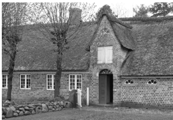
Ryc. 3. Facjatka nad głównym wejściem do budynku z miejscowości Sejerslev Południowy (obecnie w skansenie Sorgenfri koło Kopenhagi). Po lewej stronie pomieszczenia mieszkalne, po prawej inwentarskie. Źródło: fot. autora
