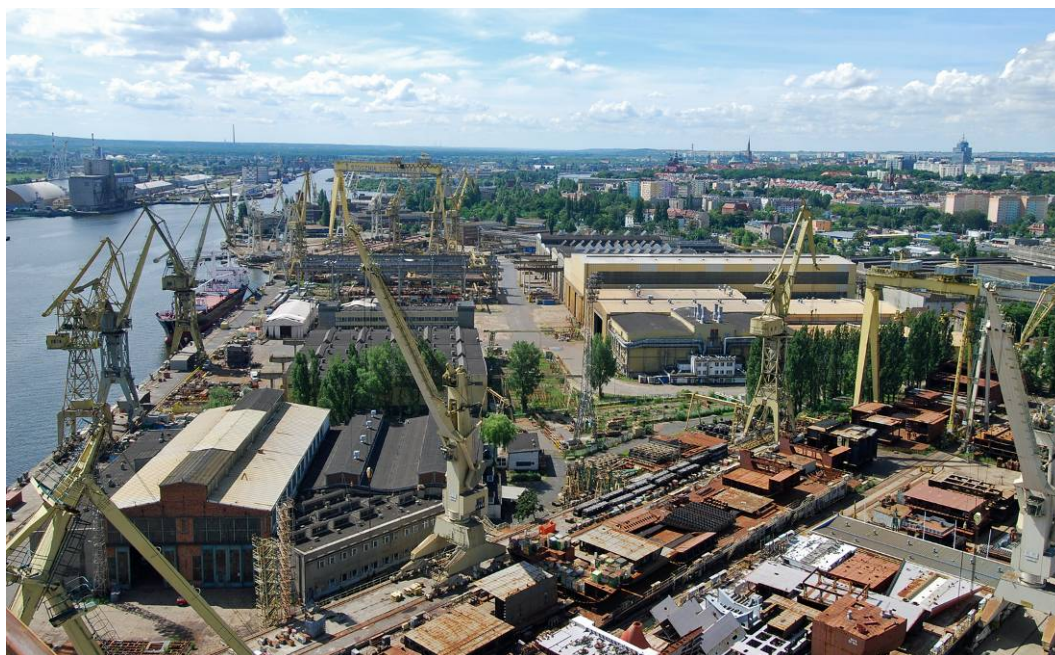
Ryc. 3. Ogólny widok terenów stoczniowych widziany z suwnicy bramowej. Źródło: il. Fot. autora Fig. 3. General view over the Szczecin Shipyard seen from the big gate crane. Source: Author's photo
