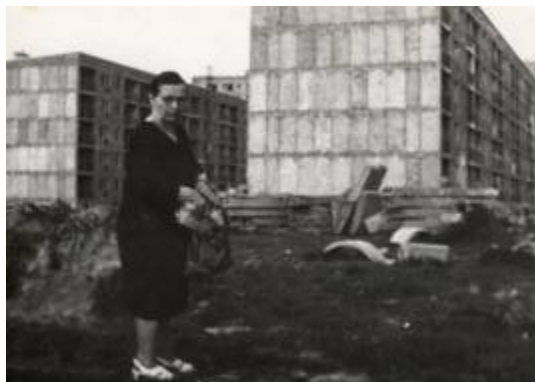
Ryc. 5. Budowa bloków przy ul. Makowskiego, 1965 r. Fig.5. Building blocks at Makowskiego St. The year 1965
