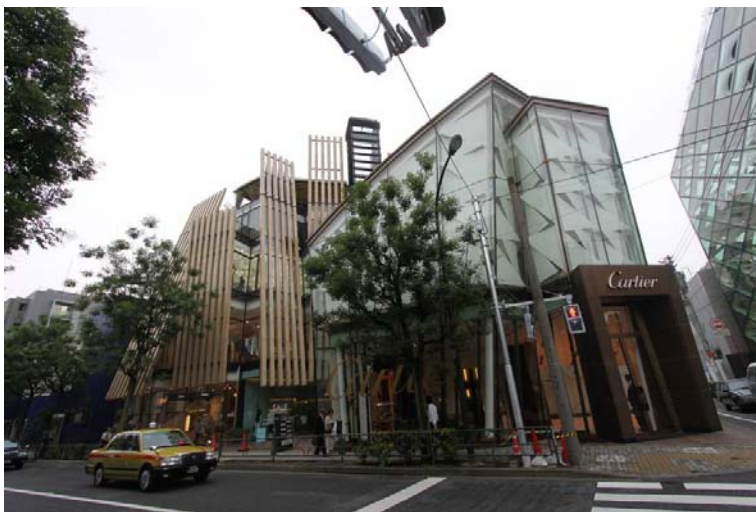
Ryc. 8. Na narożniku ulic (z prawej) Cartier Minami Aoyama, Tokio, arch. Bruno Moinard. Dalej (po lewej) The Jewels of Aoyama, arch. Jun Mitsui. Źródło: fot. R. Barełkowski
