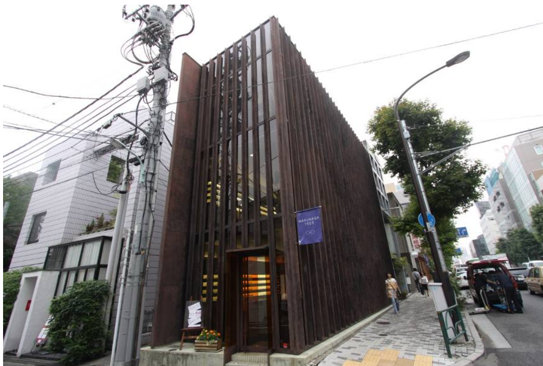
Ryc. 6. Masunaga 1905, Tokio, arch. Makoto Saito. Źródło: fot. R. Barełkowski Fig. 6. Masunaga 1905, Tokyo, arch. Makoto Saito. Source: photo R. Barełkowski
