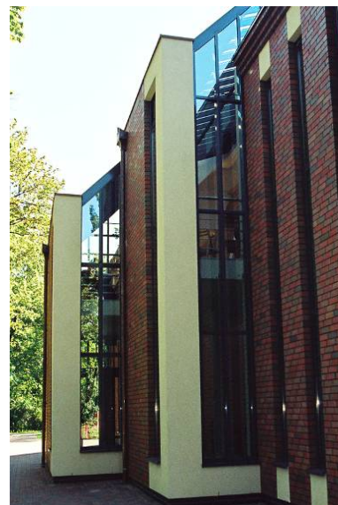
Ryc. 8. Fragment elewacji północnej kościoła. Fot. L. Czernik
