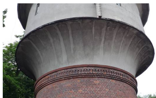
Ryc. 5. Gzyms trzonu głowicy kolejowej wieży ciśnień na stacji Kowalewo Pomorskie. Źródło: il. autora
