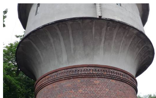
Ryc. 5. Gzyms trzonu głowicy kolejowej wieży ciśnień na stacji Kowalewo Pomorskie. Źródło: il. autora
