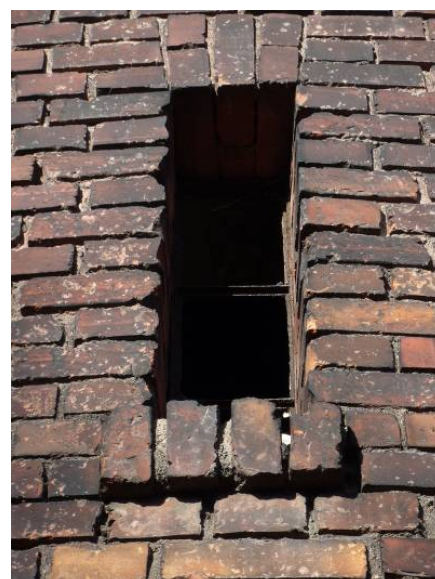
Ryc. 7. Okno doświetlające w trzonie wieży w Inowrocławiu. Źródło: il. autora
