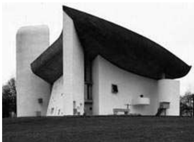
Ryc. 7. Le Corbusier, Ronchamp Źródło: J. Alazard, Les Architectes, Le Corbusier, Paris 1956
