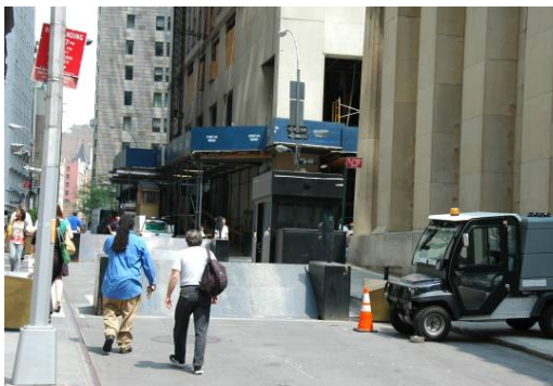
II. 6. Antyterrorystyczne zapory drogowe na Wall Street w Nowym Jorku. Źródło: fot. autora Pic. 6. Antiterrorist road defenses on Wall Street in New York. Source: author's photo
