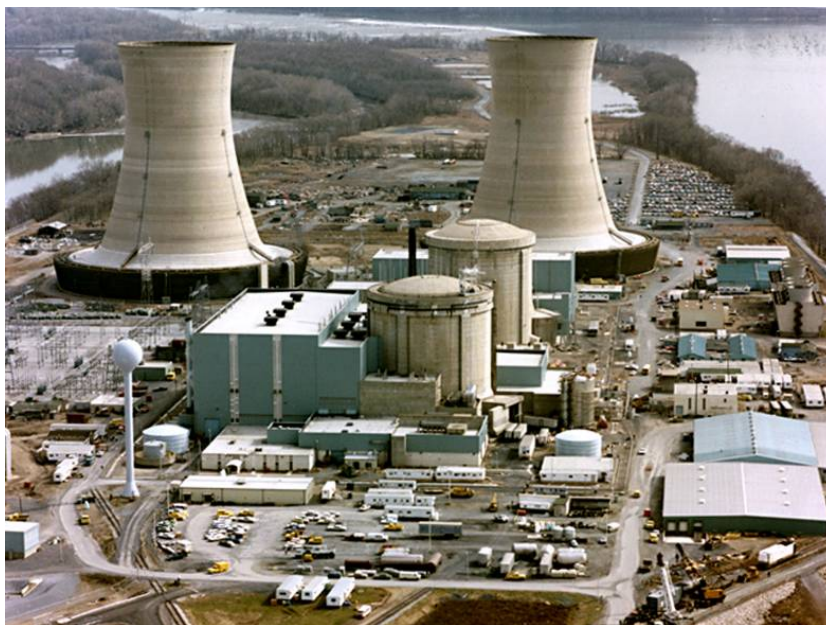
Il. 2. Elektrownia jądrowa w Three Mile Island (USA). Reaktory mieszczą dwa mniejsze obiekty przykryte kopułami, z tyłu – znacznie większe budowle – wieże chłodnicze. Źródło: Wikipedia i US Department of Energy
