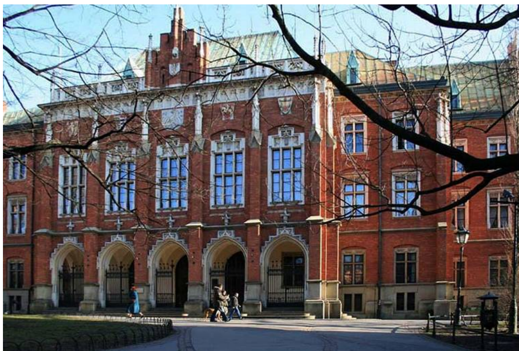
Il. 4. Kraków, Collegium Novum Uniwersytetu Jagiellońskiego – widoczny cokół kamienny ma wysokość przyziemia, tj. suterenu budynku i sięga aż do wysokości parapetów okien parteru, doskonale zabezpieczając ściany ceglane i tworząc dobrą formalną podstawę w kompozycji całej elewacji. Źródło: fot. autora
