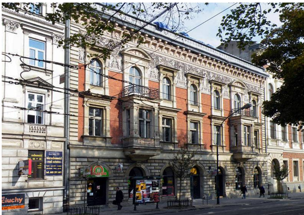
Il. 3. Kraków, ul. Basztowa. Zróżnicowanie cokołów – różne wysokości cokołów w zależności od zagospodarowania części przyziemnej budynków dla celów użytkowych. Źródło: fot. autora
