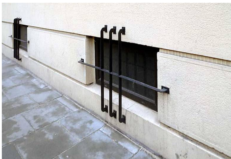
Il. 8. Kraków, ul. Retoryka – powierzchnia tynku szlachetnego „odświeżona” w trakcie współczesnej renowacji przez pomalowanie farbą elewacyjną – zamiast zwykłego umycia... Źródło: fot. autora
