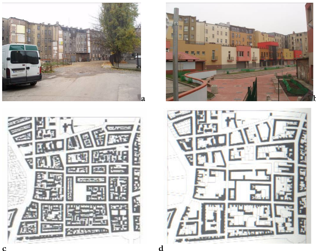
Fot. 2. Rewitalizacja kwartałów przy deptaku Bogusława w Szczecinie, przez Szczecińskie Centrum Renowacyjne (SCR): a) wyburzenie wszystkich oficyn wewnątrz kwartałów, b) dobudowa nowych kubatur w przyziemiu i parterze na funkcje handlowo-usługowe, c) Norrebrogade (Kopenhaga) - stan ok. 1960 r.; d) Norrebrogade – ten sam fragment miasta - stan po przekształceniach z lat 70-tych XX-tego wieku.
