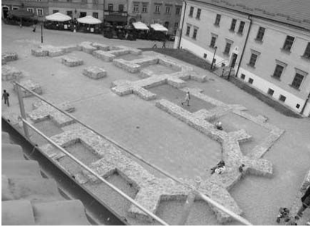
Fot. 4. Lublin: Widok na ukończony plac z kontynuacją obrysu fundamentów dawnego kościoła, utworzoną z kamienia wapienno-go; (źródło ilustracji: Archiwum Wojewódzkiego Konserwatora Zabytków w Lublinie) View on the Church Square in Lublin with the limestone construction, based on the foundation of the no - existing mediaeval church;
