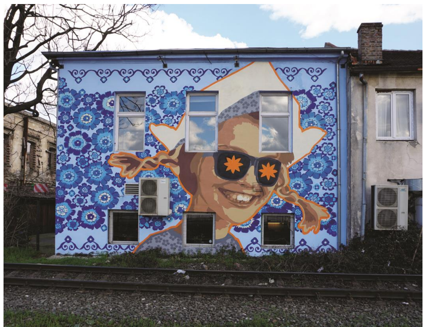
Fig. 3. Facade from the Sava river of Kulturni centar Grad . Source: phot. author Ryc. 3. Elewacja Kulturni centar Grad od strony rzeki Sava. Źródło: fot. autor
