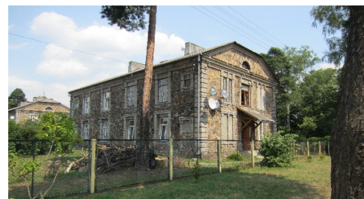
Ryc. 20. Zabudowa na osiedlu Staffa od strony ogrodu. Źródło: zdjęcie autora (2015 r.)
