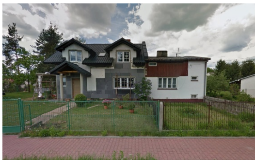
Ryc. 10. Budynek mieszkalny na osiedlu Praca, pod adresem ul. Walecznych 14, z rozbudowaną i nadbudowaną współcześnie połową. Źródło/Source: [12]
