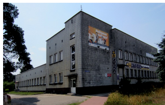
Ryc. 18. Modernistyczna przychodnia na początku ul. Staffa. Źródło: zdjęcie autora (2015 r.)
