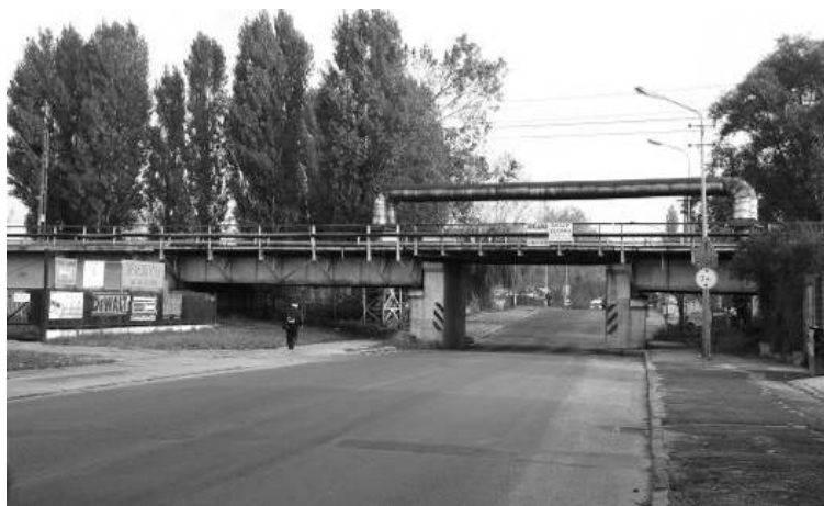
Il. 7. Wiadukt kolejowy nad ul. Heyki o niskim prześwicie, na trasie jedynej drogi dojazdowej do Kępy Parnickiej i Wyspy Zielonej. Przebudowa tego wiaduktu warunkuje możliwość wykorzystania wysp na potrzeby inwestycyjne. Źródło: fot. Z. Paszkowski
