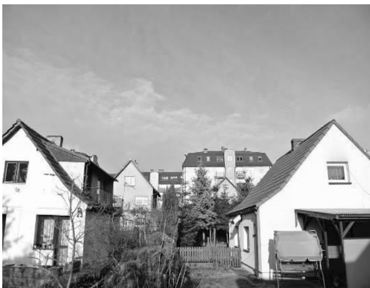
Fig. 1. Buildings at Łucznicza Street in district of Pogodno, Szczecin. Source: photographs by author. Ryc. 1. Zabudowa ulicy Łuczniczkiej w dzielnicy Pogodno - Szczecin. Źródło: zdjęcia autor.
